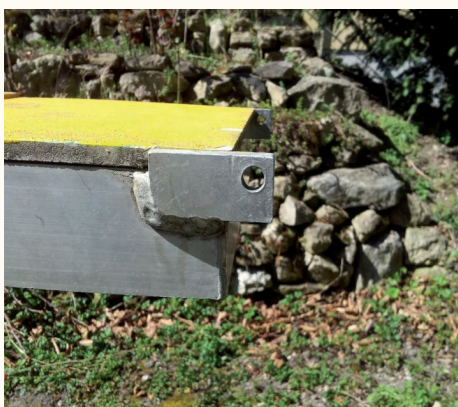
Die Verbindung zum Mittelteil hat eine recht gefährliche Ecke, die den gesandeten Belag überragt
